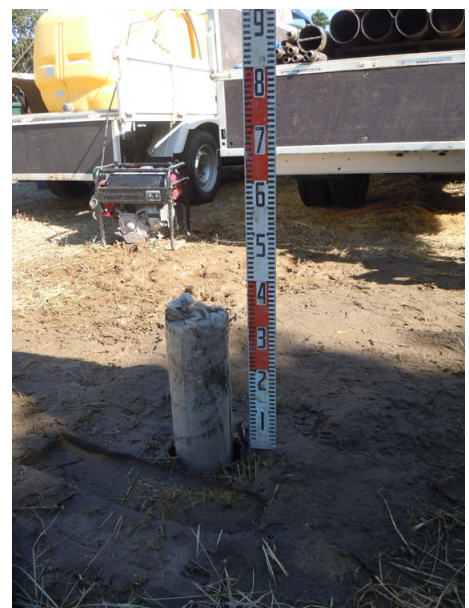
写真 ドレーンヘチマ施工例
