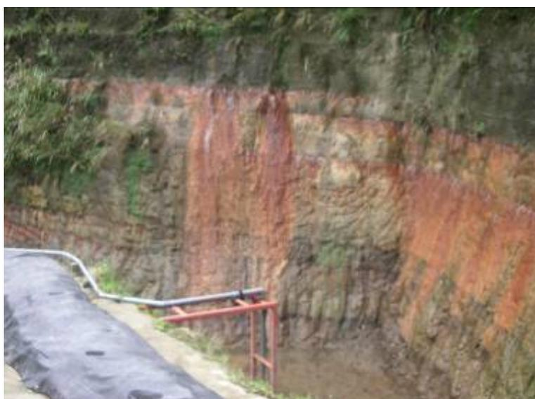
写真一七の拡大写真、2007年9月13日撮影時（写真一五）のB部分の赤色部が消滅し、A部はさらに縮小している（2007年10月5日撮影）、
