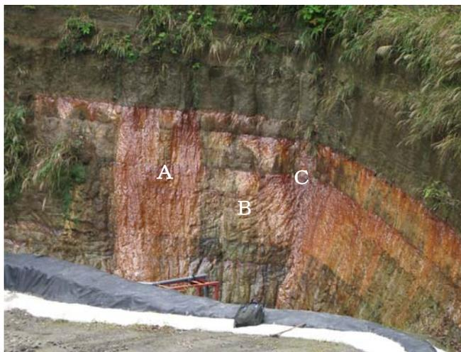
写真—1 第2処分場下流での鉄ネダレ赤壁形成現象全景2006年9月30日
