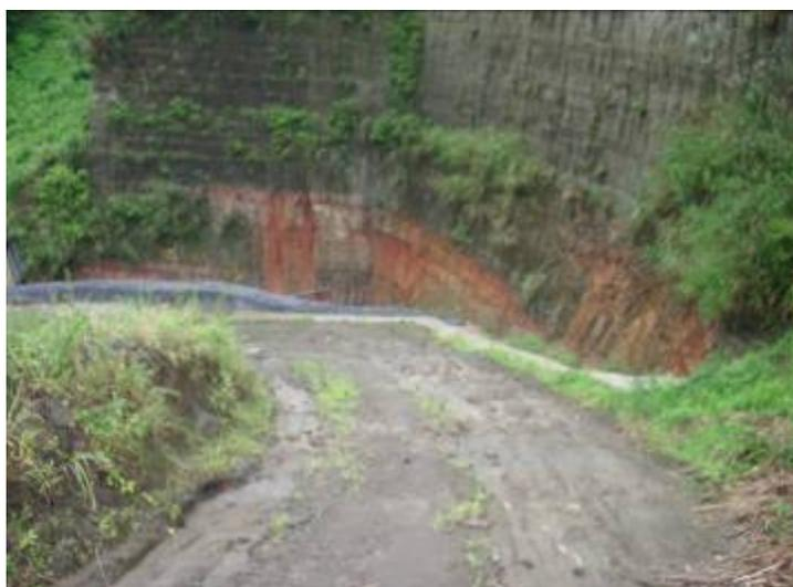
写真—4 2007年9月3日の鉄ネダレ赤壁露頭 2007年8月2日からの対策用揚水井列の揚水開始以降、写真—1（2006年9月30日）の赤色部分が縮小している。
