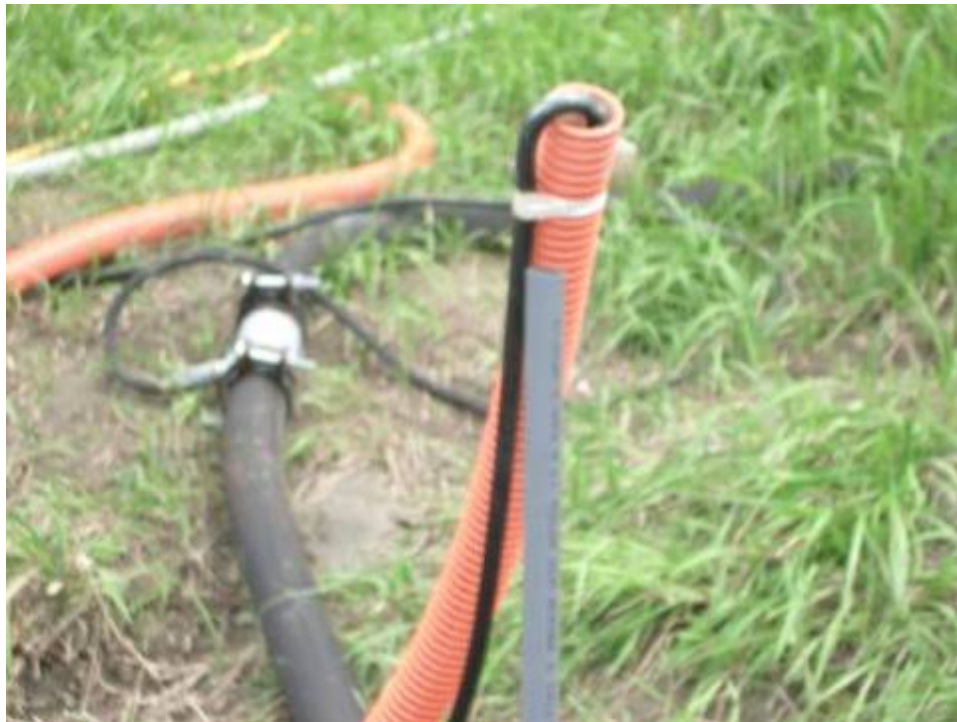
写真—3 エアーリフト井の先端
