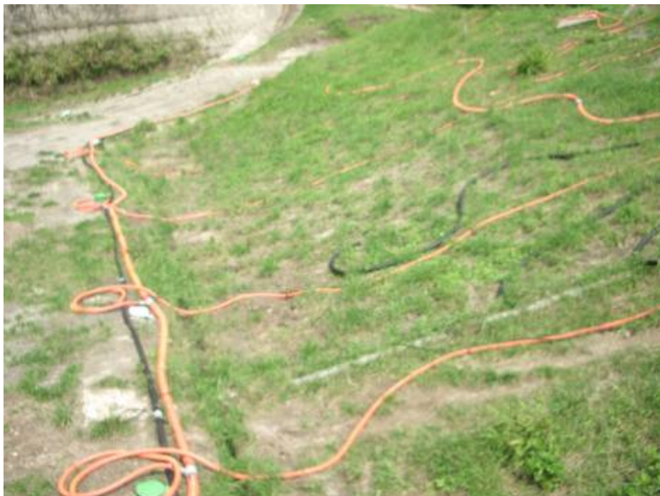
写真—1 エアーリフト・システムの配管準備
