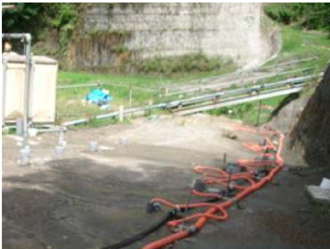
写真—4 完成したエアーリフト・システム井
